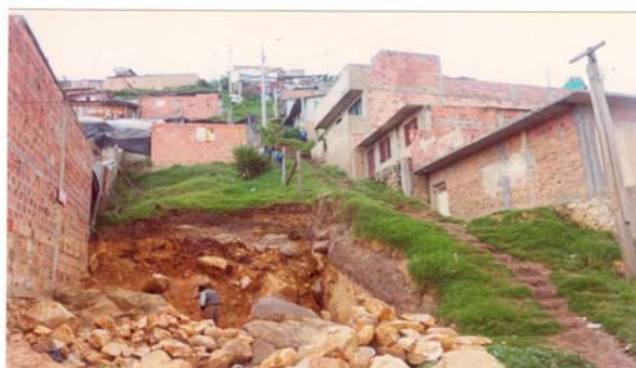
Foto Diego Caicedo. Adecuación de lote para vivienda. Barrio Paraíso.
