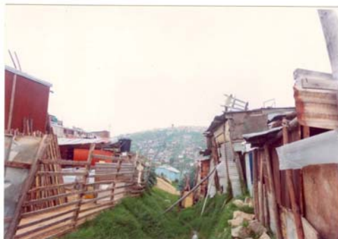
Foto Diego Caicedo. Estructura de vivienda. Barrio Paraíso
