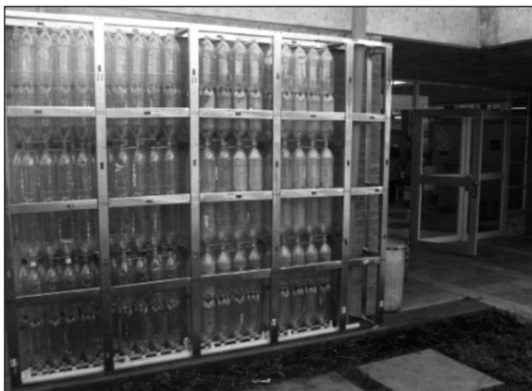
Foto 3. Construcción e instalación del muro cisterna
