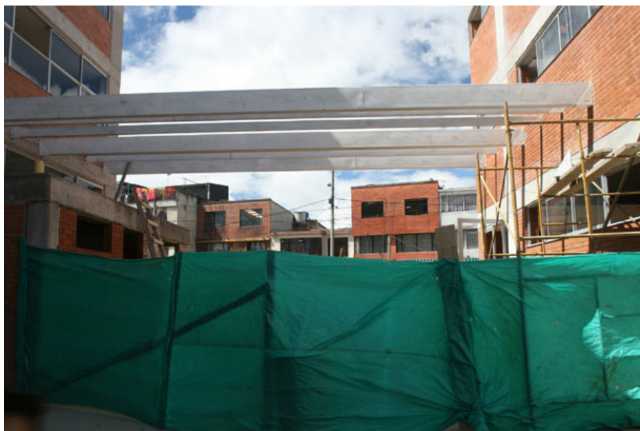
Foto 12: Colegio Técnico República de Guatemala. Edificios A y B en construcción. 2006 -2007
